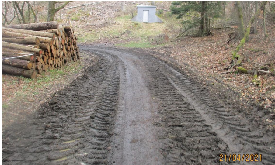
Abbildung 64: Beispiel einer Radwegeverbindung, die nach Forstarbeiten nur noch eingeschränkt nutzbar ist (eigenes Foto (VAR+, 2021))
